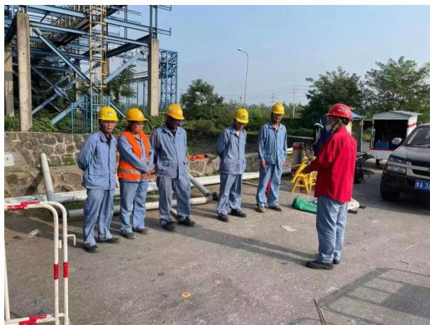
施工前文明施工培训
