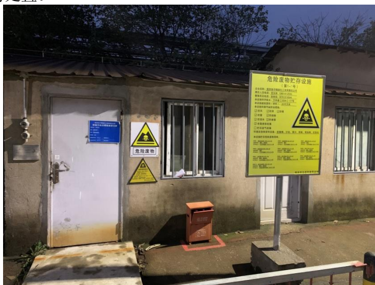
危废库标识牌
