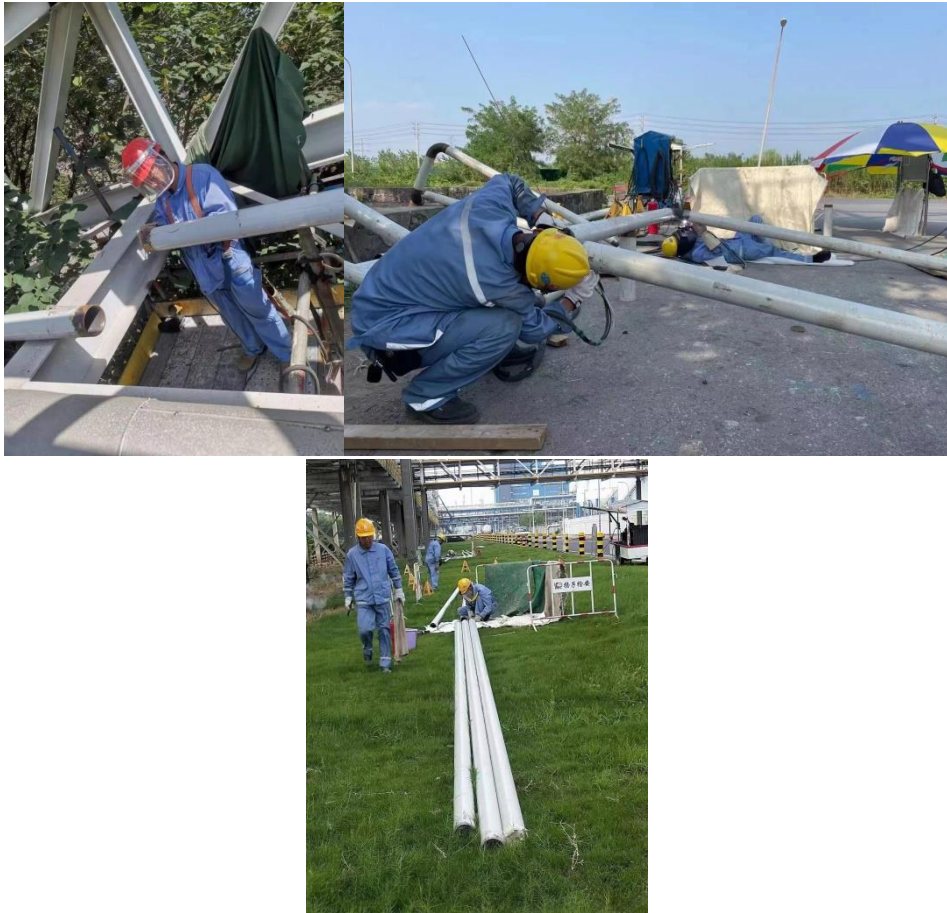
现场焊接施工
